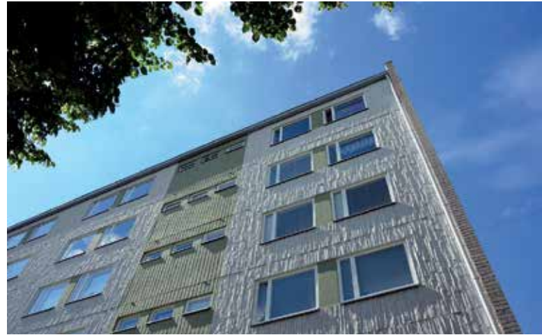
Uittamo, Rykmentintie 64. Puolimatkan vuonna 1968 suunnitteleman ja urakoiman kerrostalon julkisivua on elävöitetty harvinaisella profiloinnilla.
