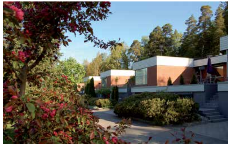
Oman aikakautensa tyyliin säilyttänyt, mutta nykyaikainen, peruskorjattu 1960-luvun rivitaloyhtiö Ispoisissa, suunnittelija arkkitehti Heikki Sarainmaa.
