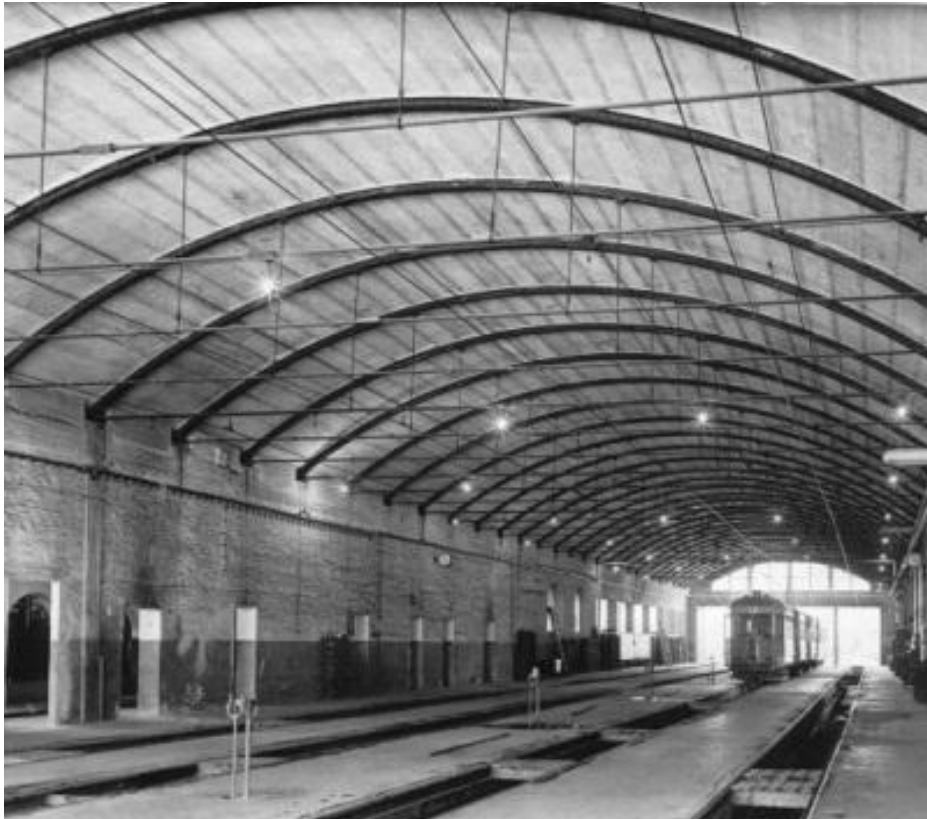
Kuva 10. Raitiovaunuhallit alkuperäisessä käytössä, Turun museokeskus.
