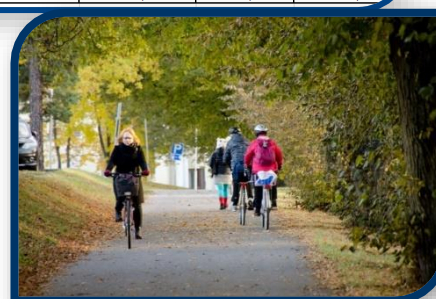
Kuva 7. Yhdistetyn jalankulku- ja pyörätien mitoitus. Valokuvan yhdistetyn pyörätien leveys on 3,6 metriä.
