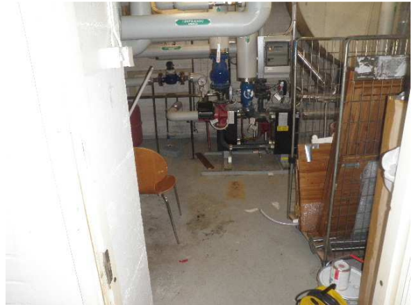
Teknisten tilojen lattiaa.
