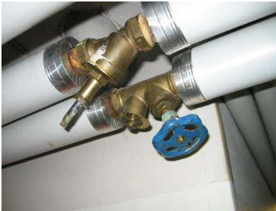
Vanha istukka ja linjasäätö-venttiili
