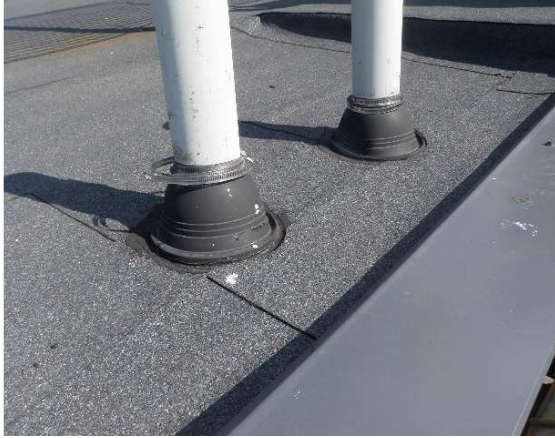
Laajennusosan katon läpivientejä.
