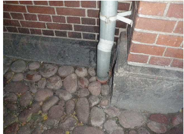
Vesikaton sade ja sulamisvesiä ohjataan sadevesiviemäriin.
