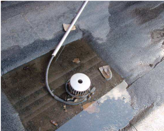
Kattokaivon sulanpitokaapeli
