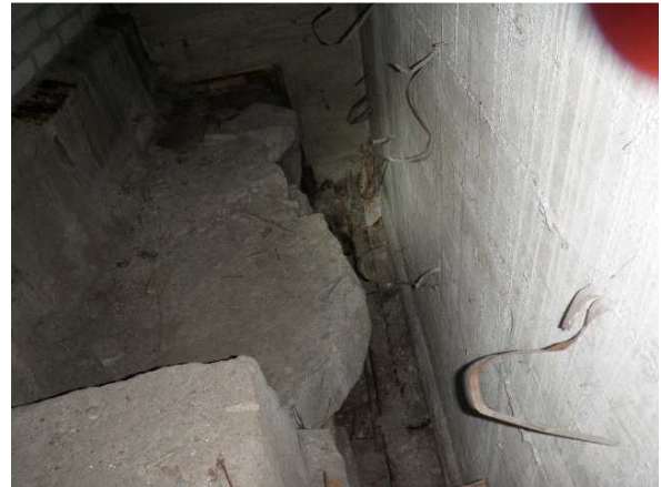
Laajennusosan ja vanhan osan liittymää.
