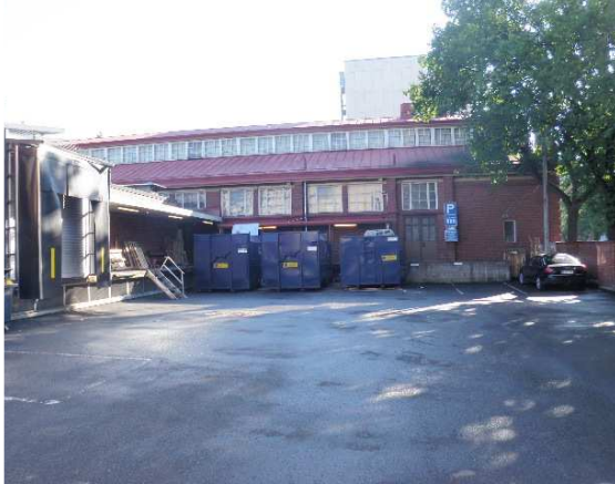
Jätehuoltopiste. Osa astioista on jäähdytetty.
