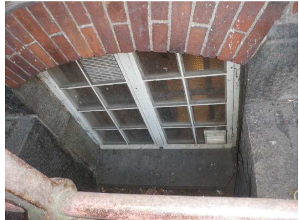
Rakennuksen sivulla ikkunasyvennyksiä.
