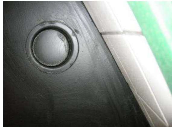
Erillissrakennuksen poistoilman yhteiskanavaventtiili
