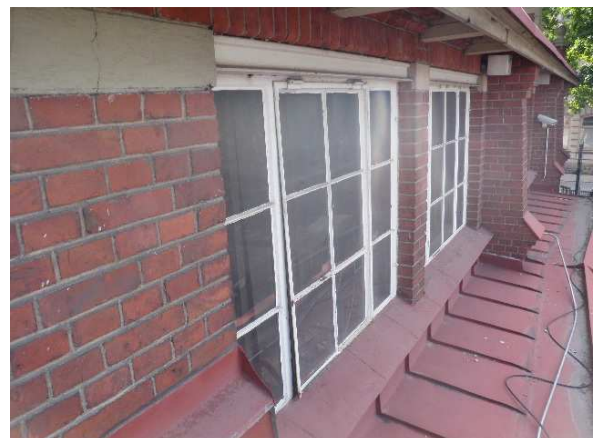
Kauppahallin yläikkunat ovat teräsrakenteiset ja pikaisen kunnostuksen tarpeessa. Kauppahallin ikkunoita.
