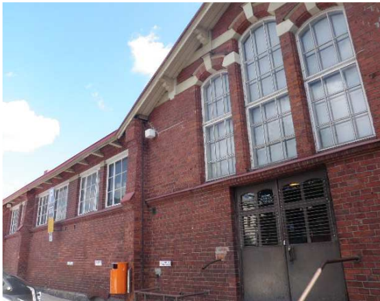
Tiiliverhottu julkisivu on kohtuullisessa kunnossa. Lisärakennuksen rapattu julkisivu.
