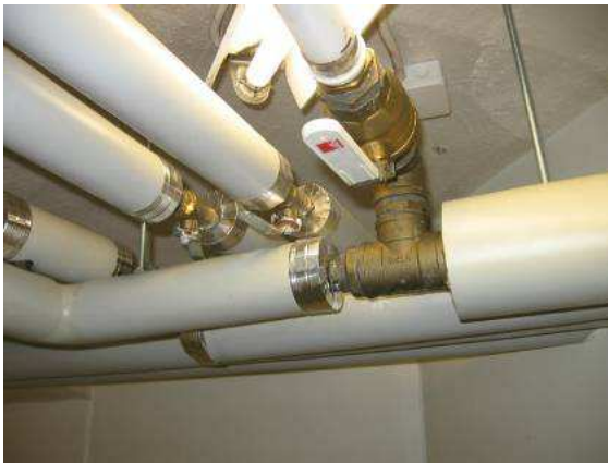
Käyttöveden sulkuventtiileitä
