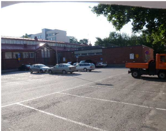
Parkkialueen asfalttipinta on kohtuullisessa kunnossa eikä sille ole odotettavissa korjaustarvetta
