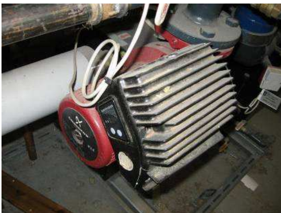
Lämmitysverkoston kiertovesipumppu.
