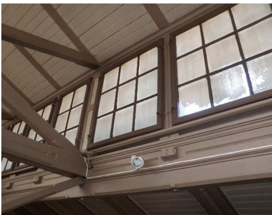
Kauppahallin yläikkunat ovat teräsrakenteiset ja pikaisen kunnostuksen tarpeessa. Kauppahallin ikkunoita.
