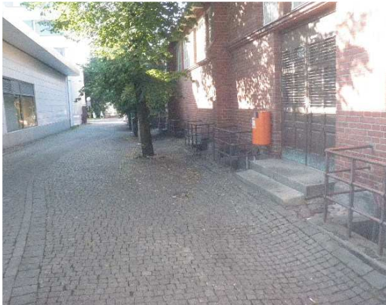
Rakennuksen sivulla kulkukäytävällä kasvaa puita
