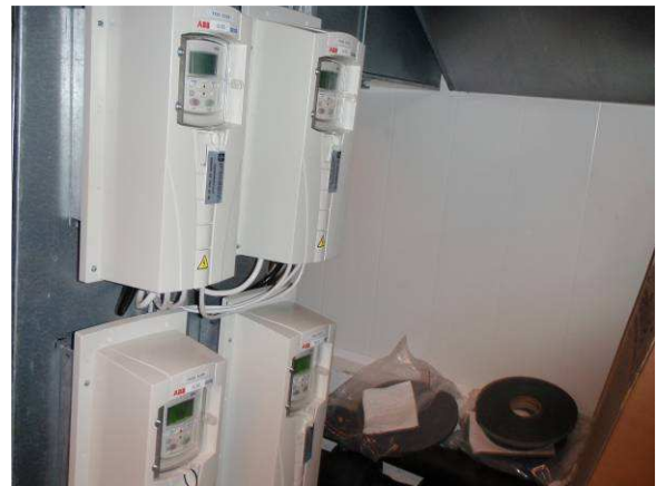
Puhaltimien toimintaa ohjataan taajuusmuuttajilla.
