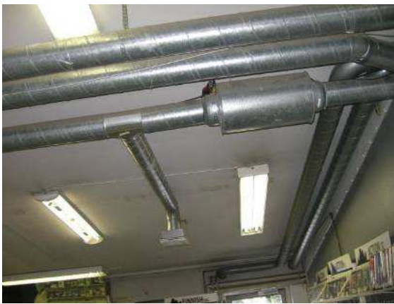
Ilmanvaihtokanavia erillISRakennuksessa
