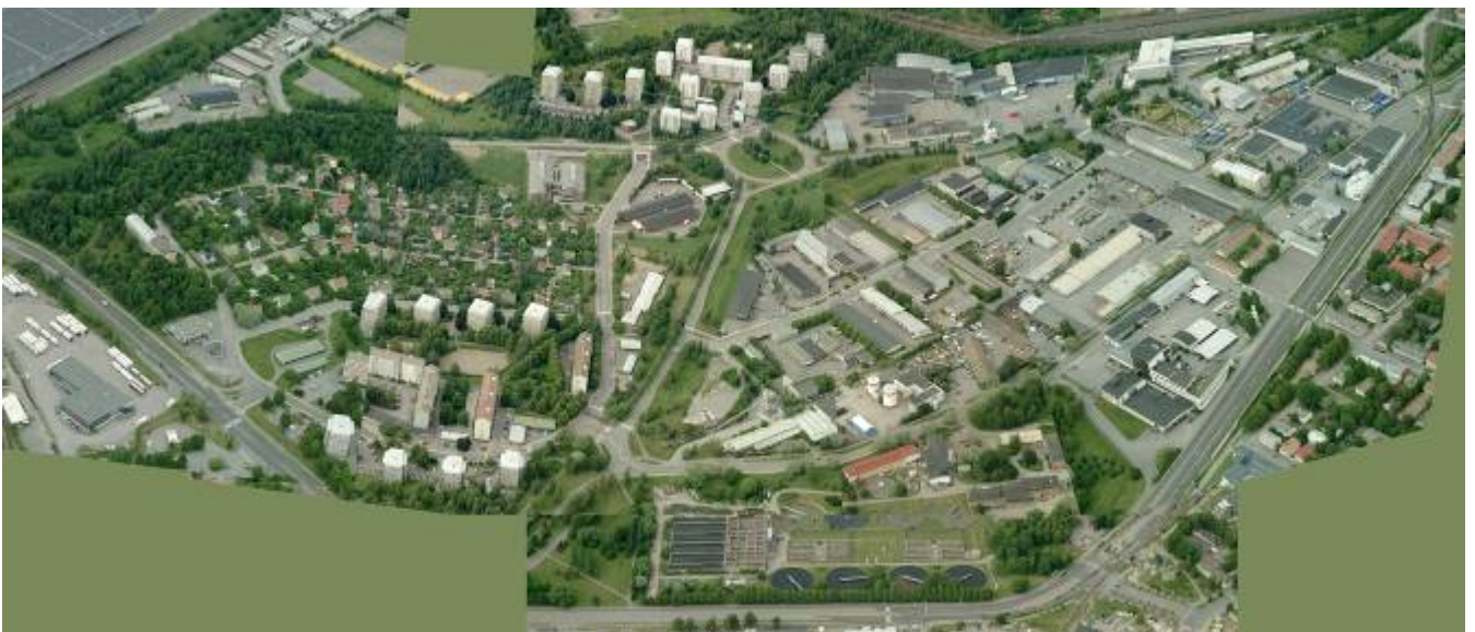
Kuvakooste Patterihaan ja Iso-Heikkilän asuntoalueista, lakkautettu vedenpuhdistamo ja teollisuusalue
